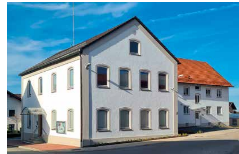
Im Jahr 2024 wurde auch das Rathaus renoviert: Es erhielt einen frischen Anstrich, der Blitzschutz wurde installiert, und die Schneefanggitter auf dem Dach wurden ergänzt.
