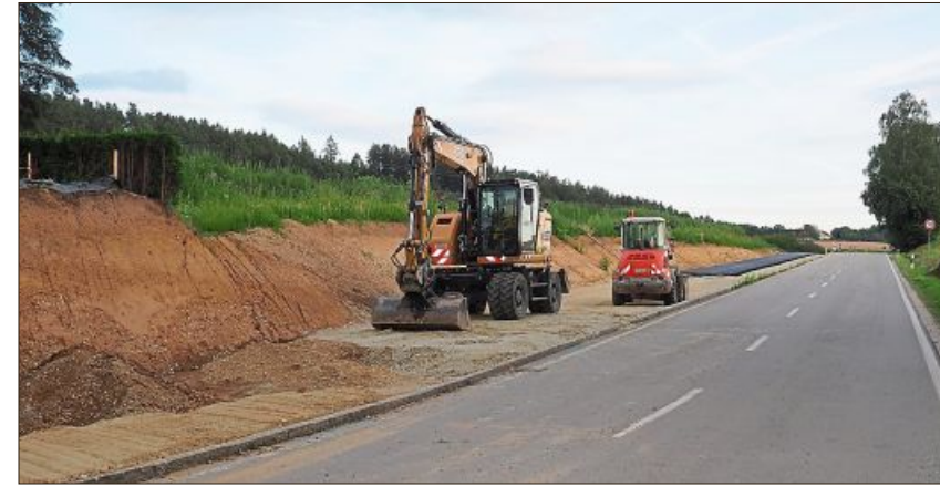
Die Arbeiten zum Radweg zwischen Bubach und Dittenkofen gehen voran.
