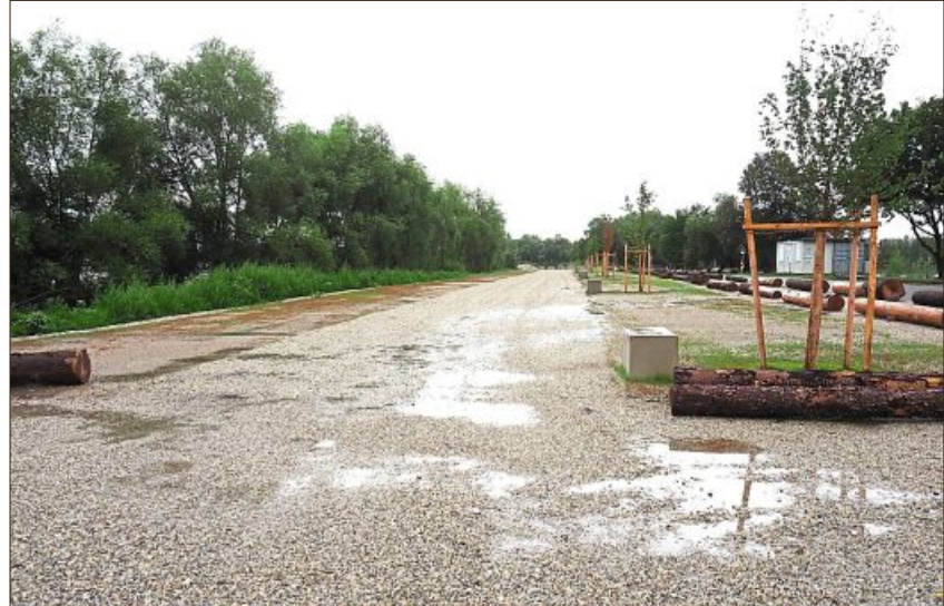
120 neue Parkplätze wurden durch die Firma Mossandl geschaffen.
