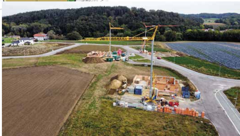
Es wird schon gebaut.
