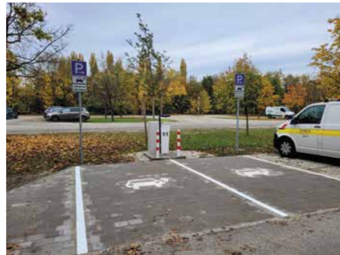
...am Parkplatz Schwaigener Straße/Verkehrsübungsplatz
