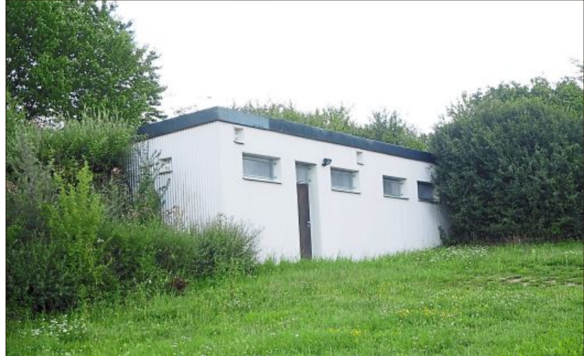
Die Wasserversorgung Mammung mit allen Liegenschaften geht auf die Gemeinde über. Fotos: Monika Ebnert
