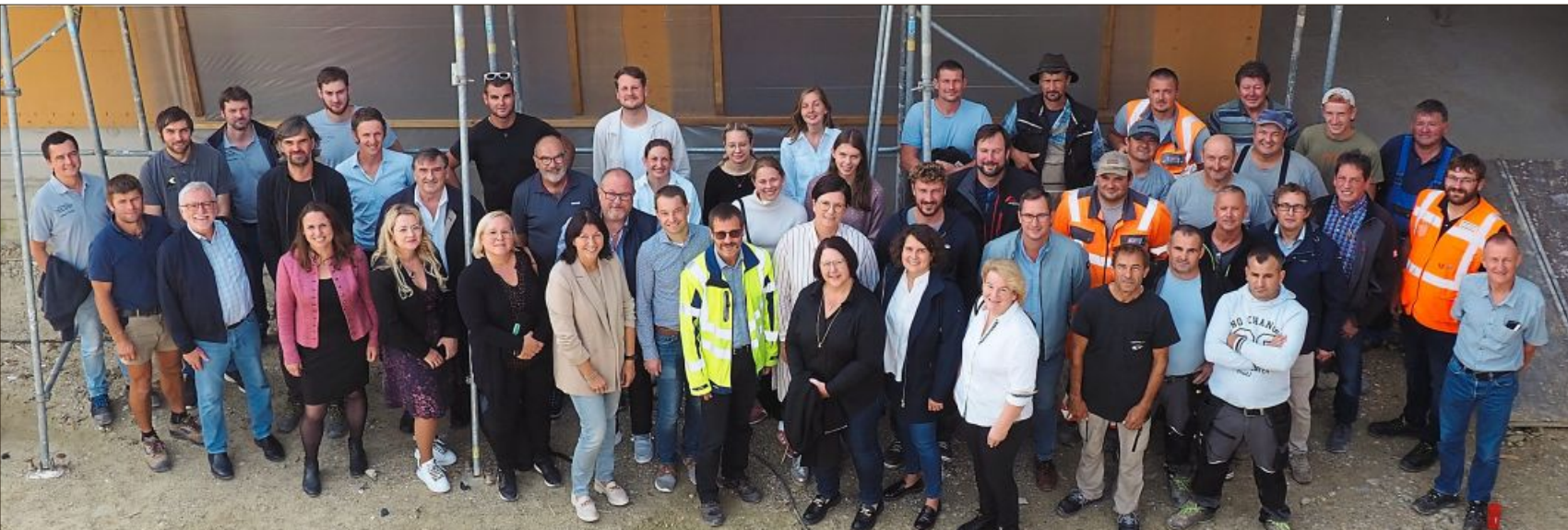
Das Richtfest zum Neubau des „Haus für Kinder – Haus 2“ konnte gefeiert werden.
