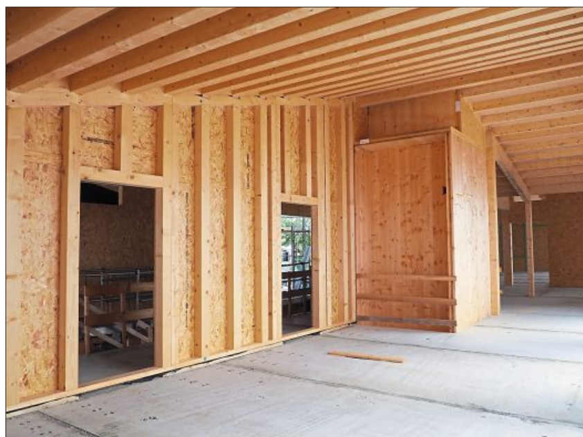
Innen wie außen: Es wird auf Holz als Baumaterial gesetzt.
