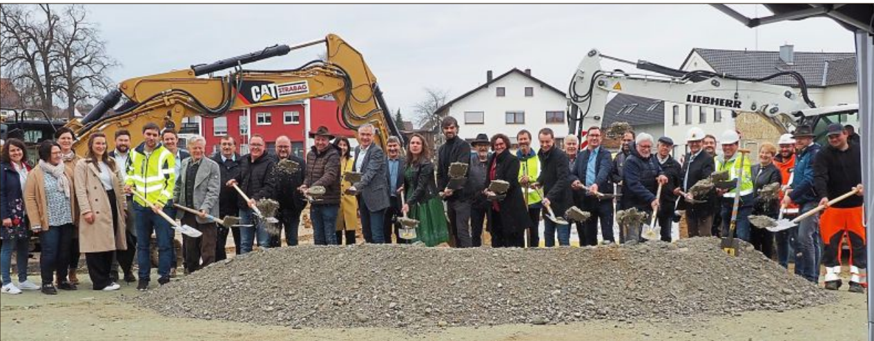
Der offizielle Spatenstich ist gemacht.
