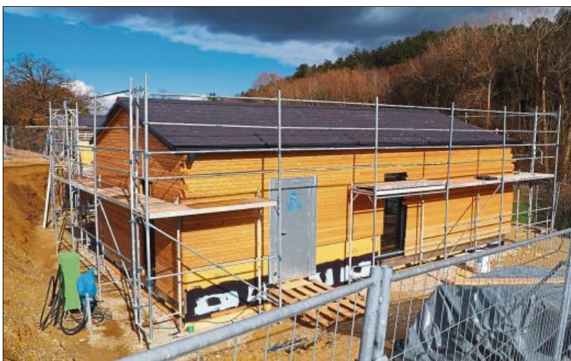
Der Neubau des Naturkindertages geht gut voran.
