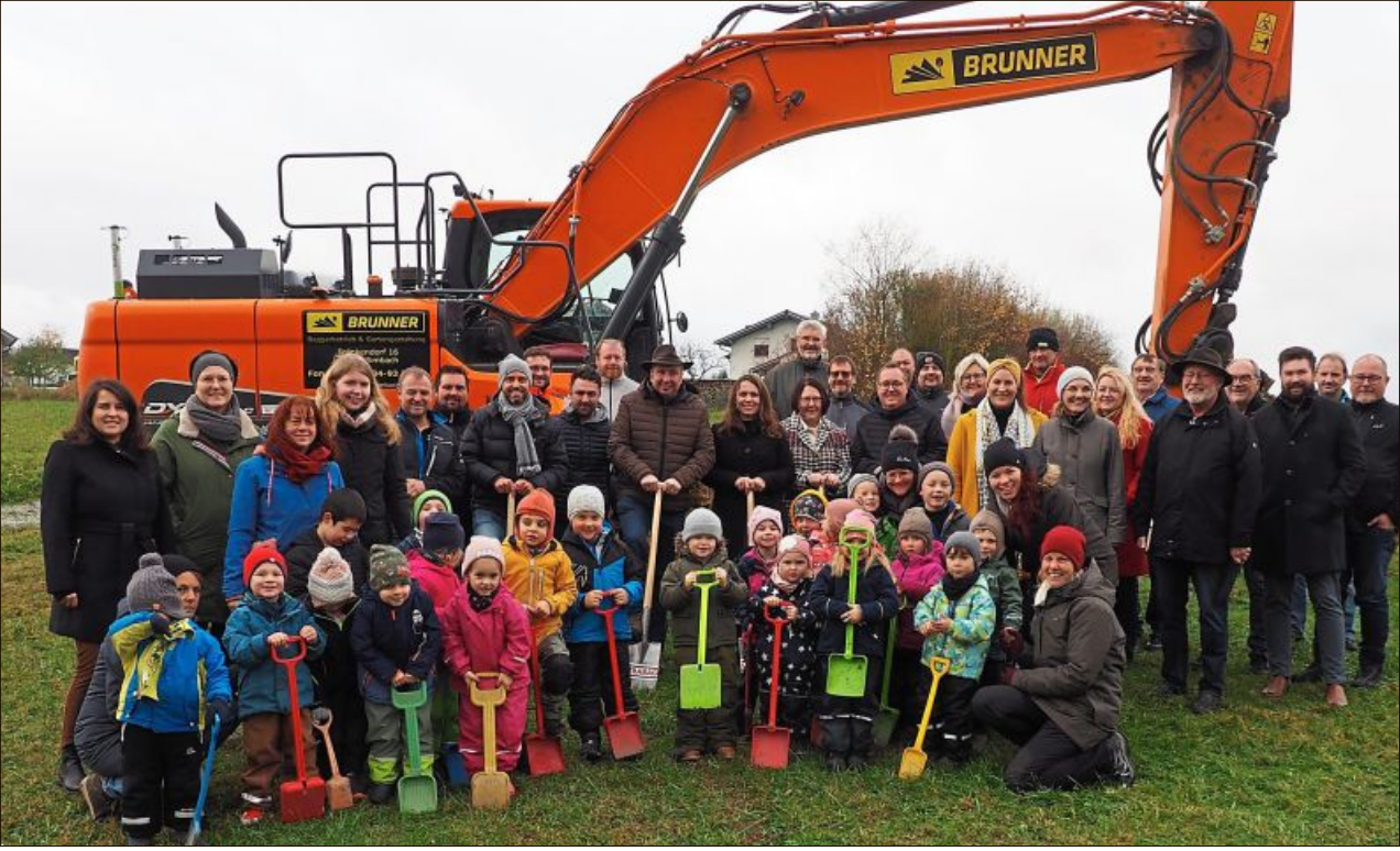
Der Spatenstich zum Naturkindergarten der Gemeinde Mamming ist gemacht.
