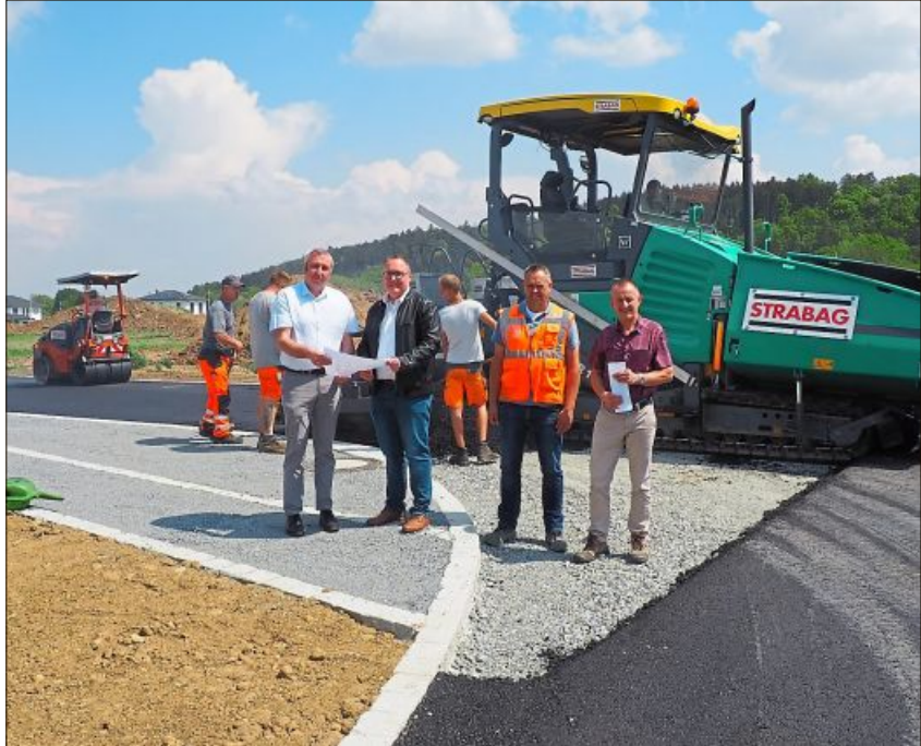
Während der Asphaltierungsarbeiten – jetzt geht es an den Verkauf. Fotos: Ebnet
