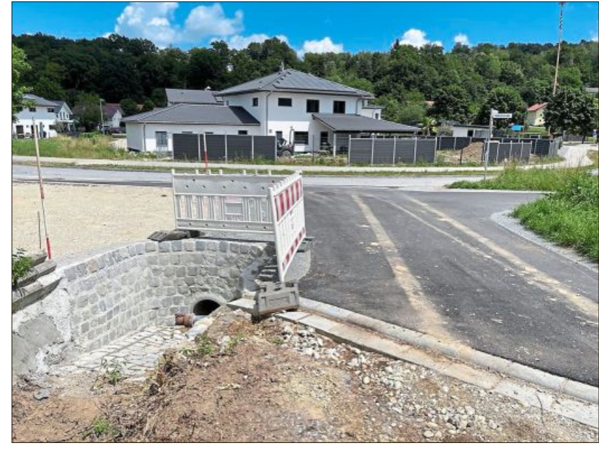
Die Baustelle in Bubach zur Verbesserung der Entwässerung.
