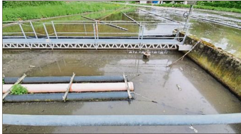
Die Ertüchtigung Kläranlage wird ein Großprojekt.
