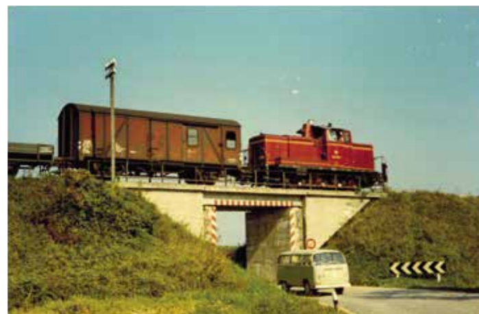
Letzte Lok fährt über die Hofer Brücke
