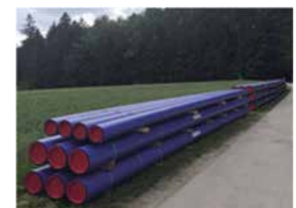
Rein mit den neuen Leitungen – für sauberes Trinkwasser – für unsere Kunden!
