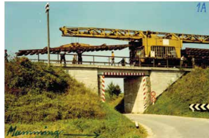
Eisenbahnbrücke Hof - Schienenabbau
