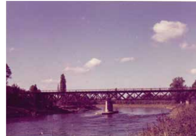
Eisenbahnbrücke über die Isar nach Mamming
