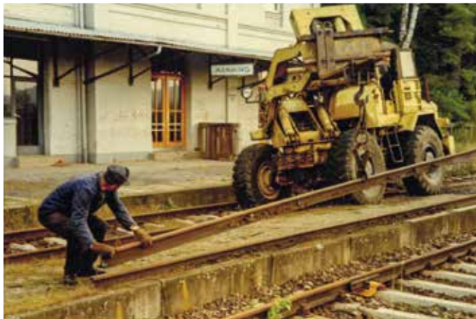
Schienenabbau am Bahnhof Mamming
