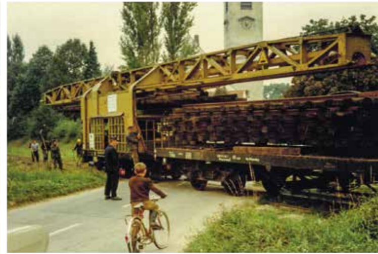
Demontagekran – Schienenabbau
