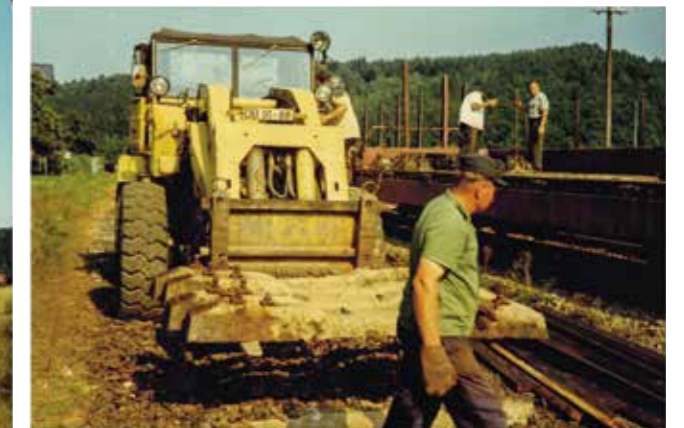
Schienenabbau mit Lader
