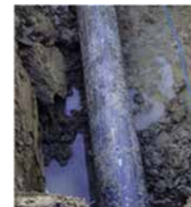
Raus mit den alten Leitungen!
