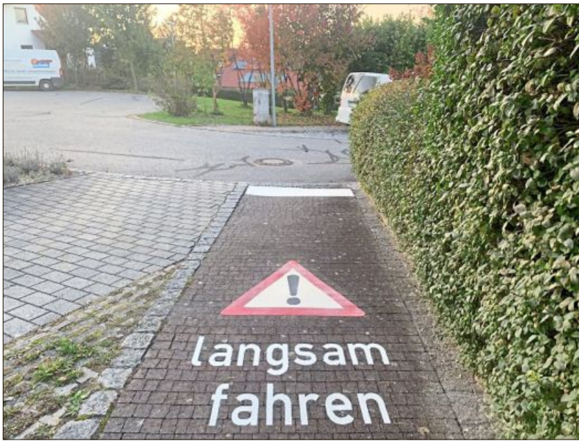
Der entstandene Gehweg an der Prangstraße mit entsprechendem Hinweis.
