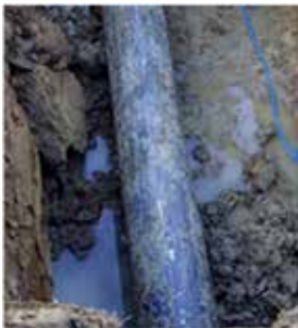
Raus mit den alten Leitungen!
