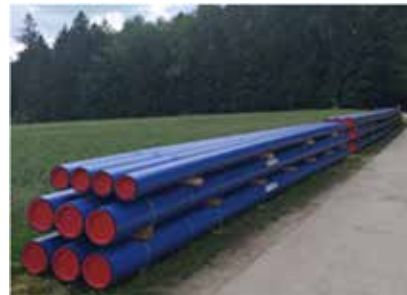
Rein mit den neuen Leitungen – für sauberes Trinkwasser – für unsere Kunden!
