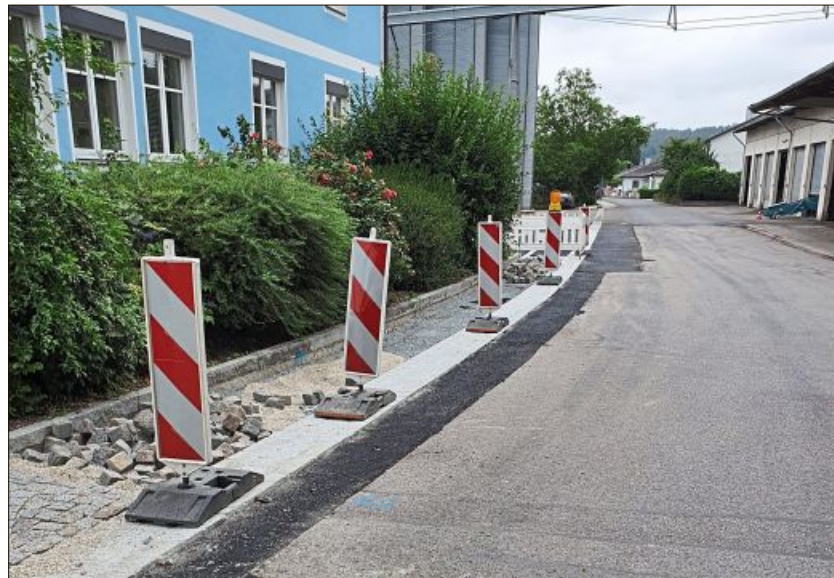
Die Baumaßnahme in der Bahnhofstraße.
