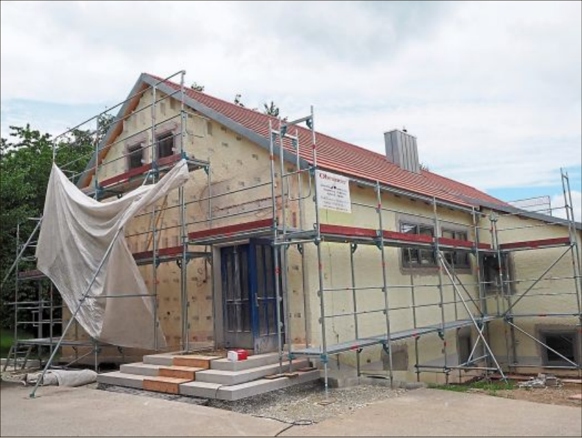
Der Umbau der Grundschule Bubach geht voran.
