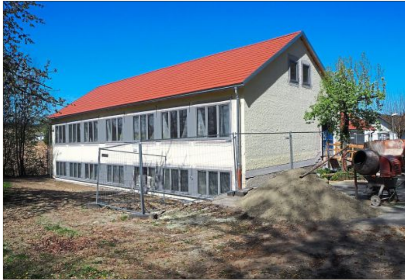
Das Schulgebäude in Bubach wird umfangreich saniert.
