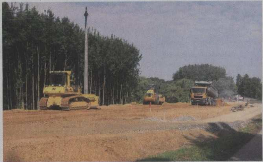
Die Baumaßnahme „Neue Isarbrücke Mamming“ nähert sich dem Ende.
