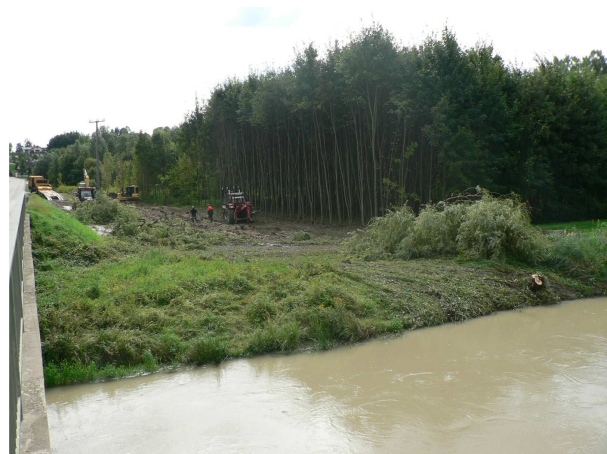
Rodungsarbeiten und Baufeldfreimachung auf der Mamminger Seite.
