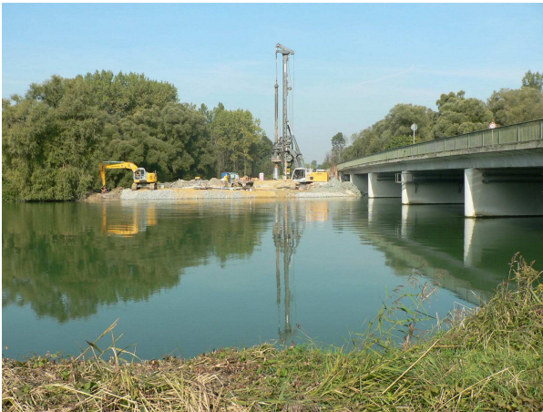
Die Gründung der Widerlager erfolgte mit Großbohrpfählen, hier auf der Seite Mammingerschwaigen.
