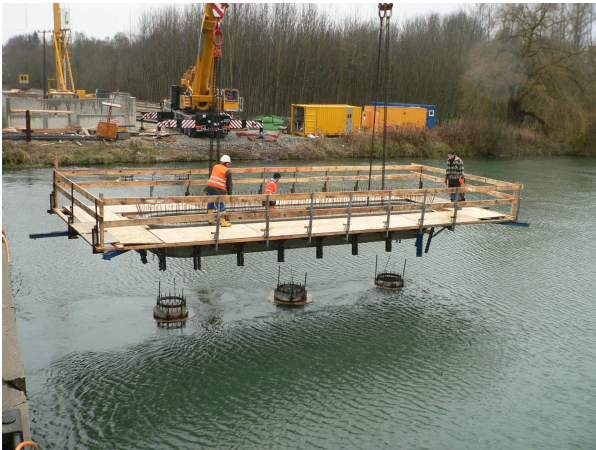
Die Montage der Pfeilerfertigteile
