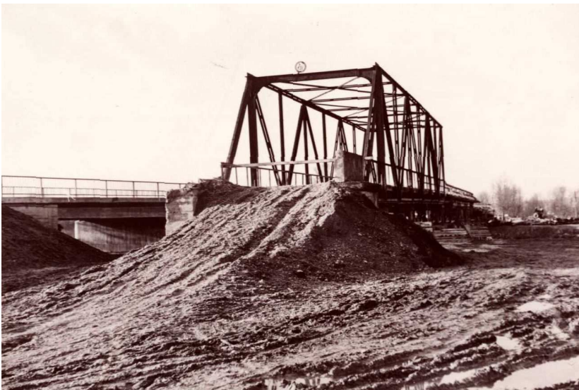
Die alte eiserne Brücke aus dem Jahr 1899 kurz vor ihrem Abriss, daneben die 1954 fertig gestellte neue Brücke, die kaum älter werden sollte, als ihre Vorgängerin.
