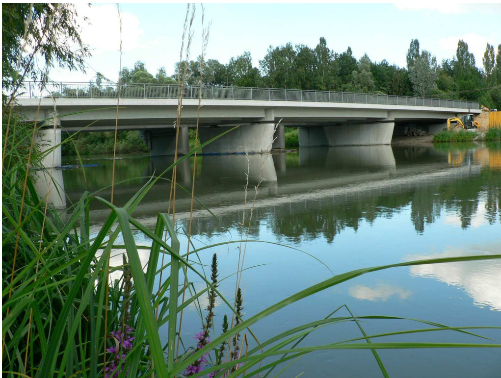
Isarbrücke Maming im Zuge der Kreisstraße DGF 11, erbaut 2010/11.
