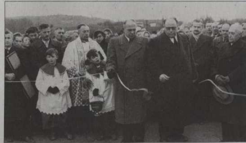
1954 gaben Bürgermeister Paul Heckner und Landrat Dr. Josef Hastreiter die Brücke für den Verkehr frei.
