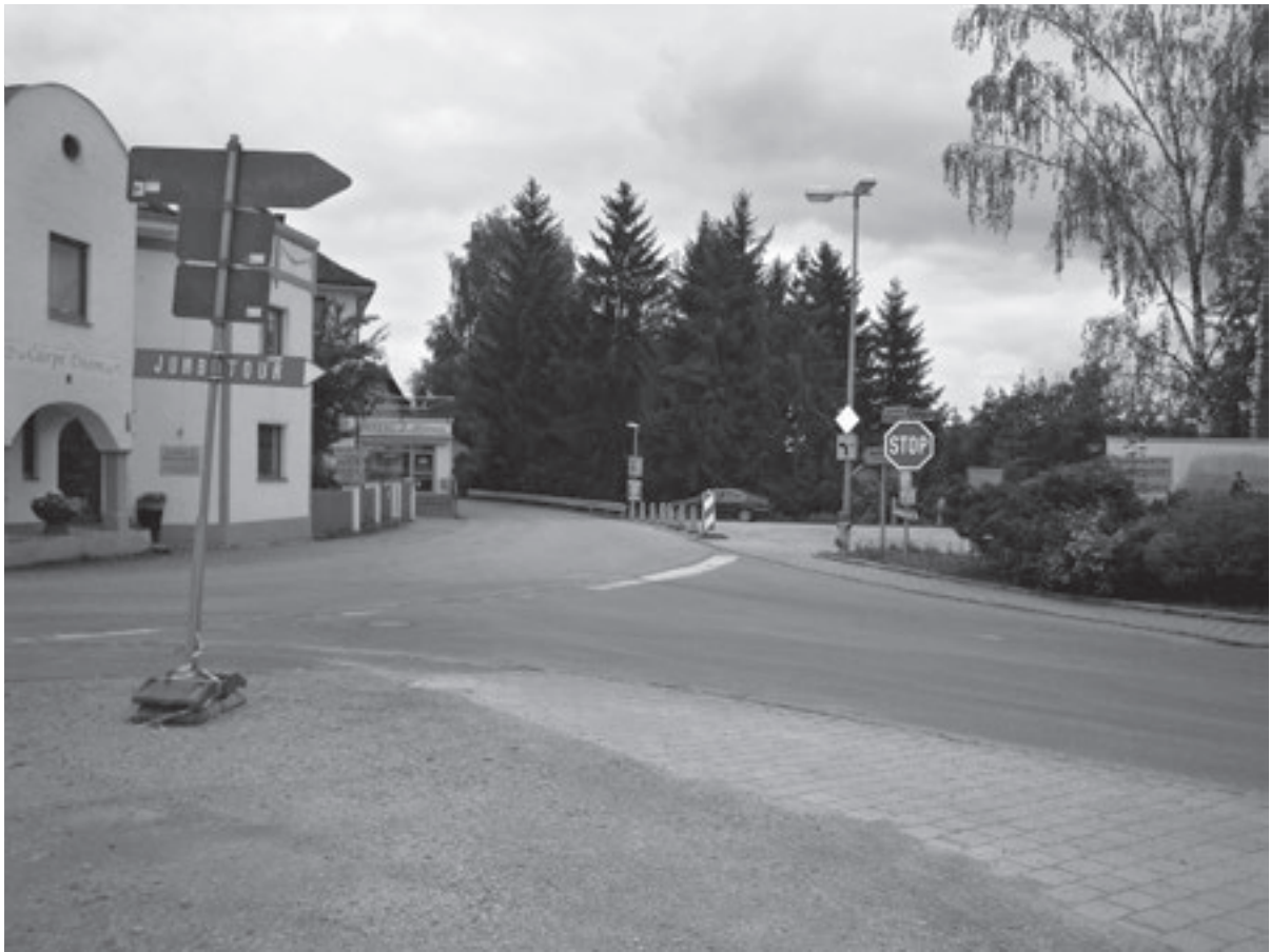
Die „alte“ Fischerwirtskreuzung vor der Umbaumaßnahme.
