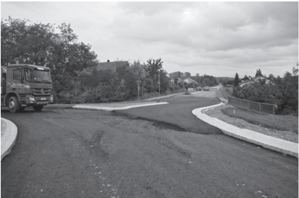
Bau des Kreisverkehrs Mammingerschwaigen.
