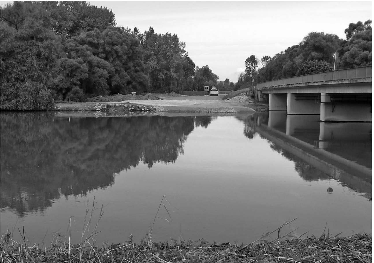
Baubeginn Neubau Isarbrücke
