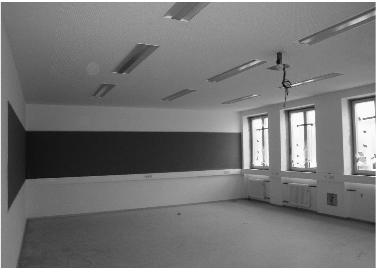
Energetische Sanierung Schule Mamming
